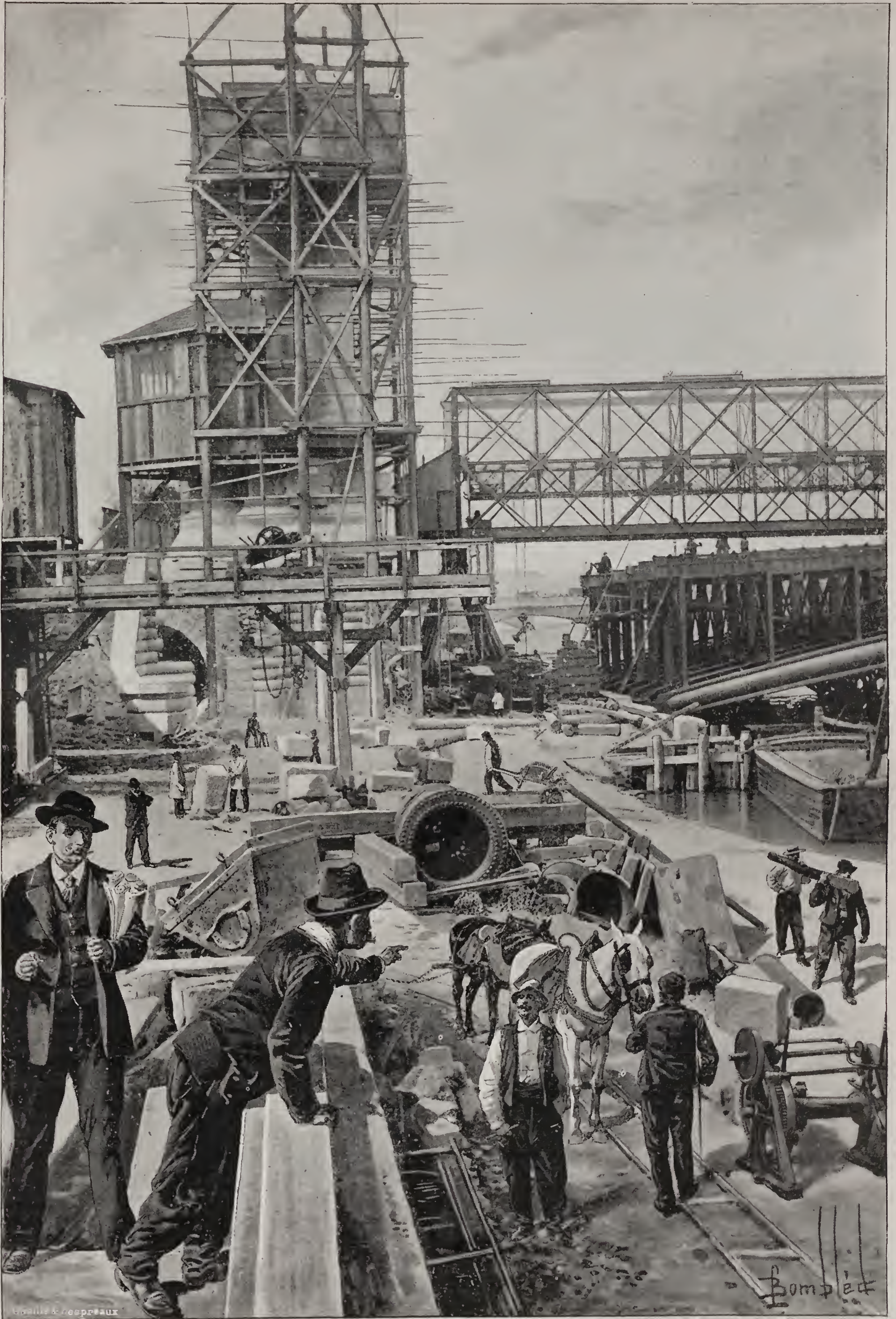
LE PONT ALEXANDRE. — Un des pylones de la rive droite, avec ses échafaudages.
